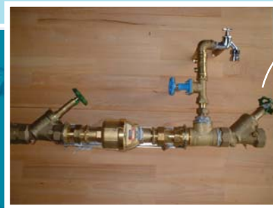
Industriële aftakking met minibinneninstallatie
