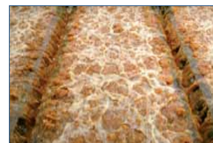
Spoelen van een zandfilter
