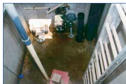
Watervangput - putkamer (inwendig)
