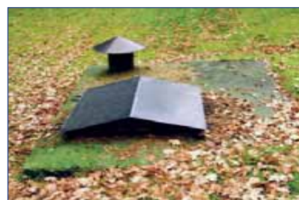
Watervangput - bovengronds gedeelte
