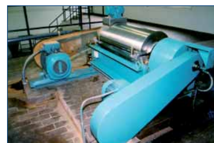
Slibverwerking met centrifuge
