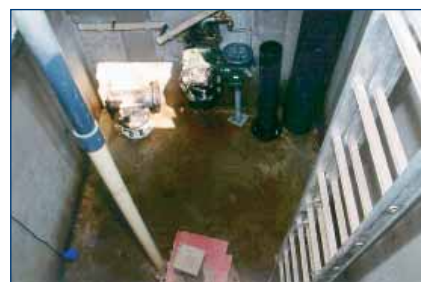
Watervangput - putkamer (inwendig)
