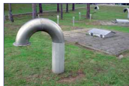
Reinwaterkelder - bovengronds gedeelte
