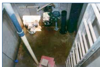
Watervangput - inwendig gedeelte
