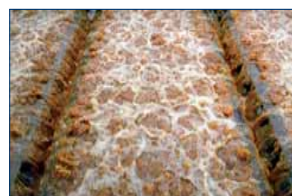
Spoelen van een zandfilter
