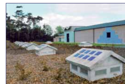
Reinwaterkelder - bovengronds gedeelte
