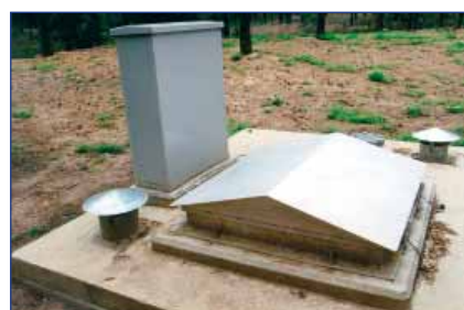
Watervangput - bovengronds gedeelte
