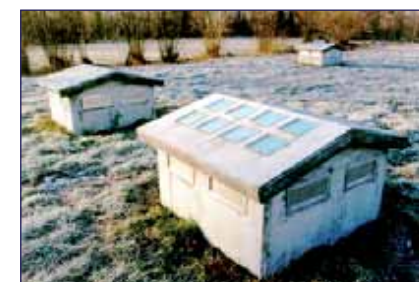
Reinwaterkelder - bovengronds gedeelte
