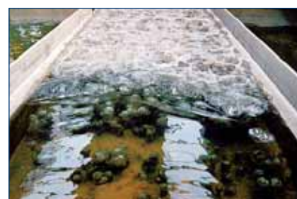
Spoelen van zandfilter - beginfase
