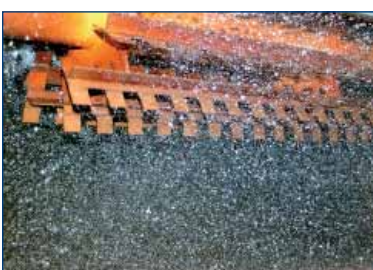
Borstelbeluchters (grondwater Ravels/Arendonk)
