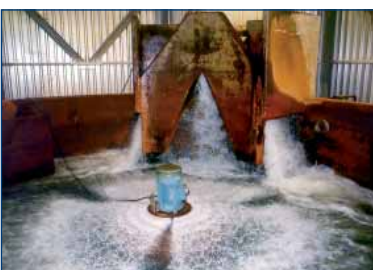
Oppervlaktebeluchter (grondwater Oud-Turnhout)
