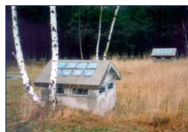
Reinwaterkelder - bovengronds gedeelte
