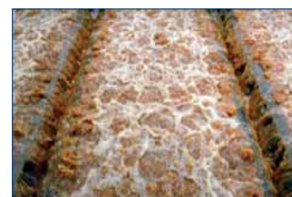
Spoelen van een zandfilter
