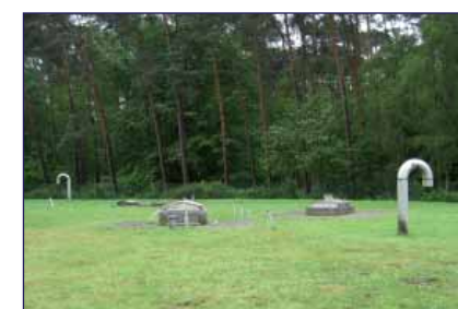
Reinwaterkelder - bovengronds gedeelte
