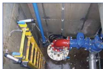
Watervangput - putkamer (inwendig)
