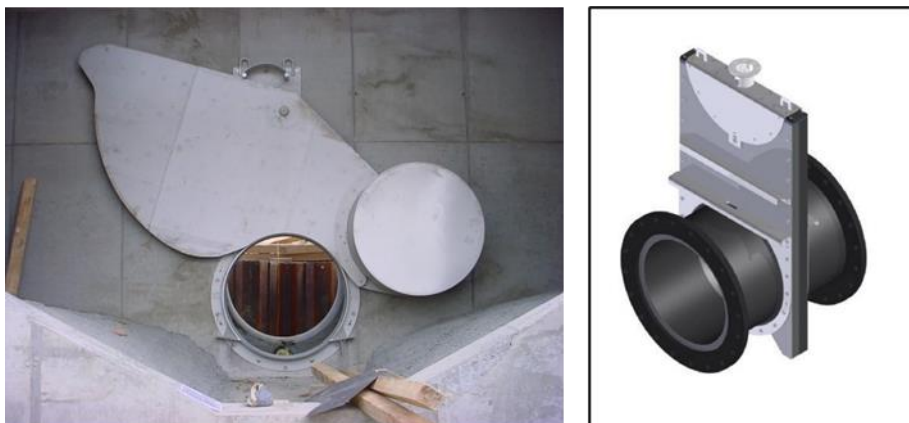
Figuur 48: Links: Debietregelaar. Bron: Morselt.com. Rechts: Regelbare afsluiter. Bron: KWT.be.
