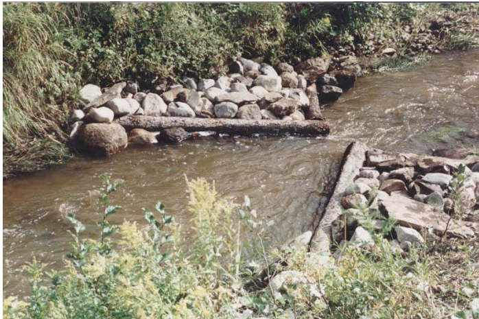
Figuur 41: Stroomdeflector met stenen en hout. Bron: www.afterwildfire.org .
