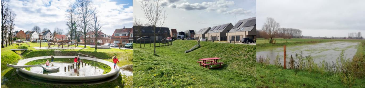
Figuur 6. Bovenlokale buffers kunnen meerdere functies combineren. Links en midden wordt de bufferfunctie gecombineerd met een recreatieve functie, waar de foto rechts infiltratie en buffering combineert. Locatie: (links) Kontich, (midden) Kortrijk en (rechts) Kruisem. © Aquafin
