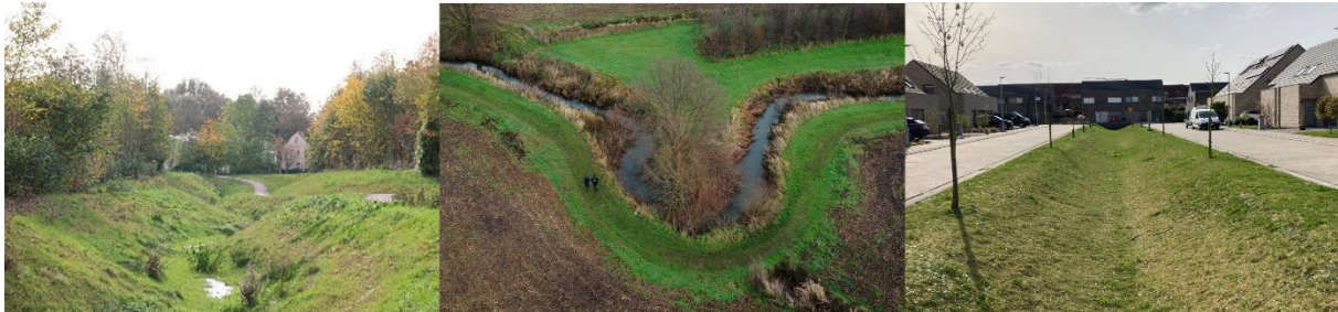
Figuur 8. Blauwgroene afvoerwegen bieden een breed spectrum aan inrichtingsmogelijkheden. (Links) Vuilbeek te Wezembeek-Oppem als blauwgroene verbinding ©VMM; (midden) meanderende beek met bufferstroken ©VMM; (rechts) verlaagd aangelegde groenzone in een woonwijk in Kortrijk © Aquafin.
