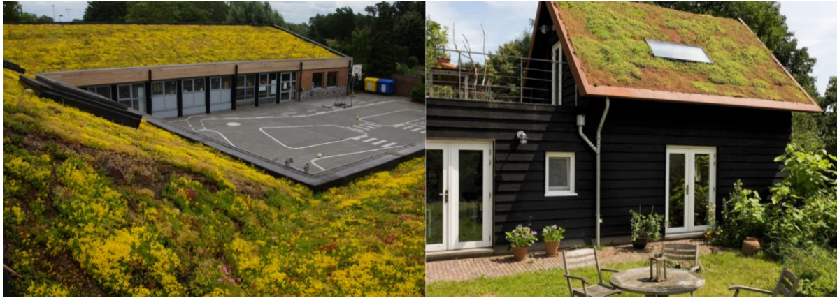
Figuur 10. Voorbeelden van een groendak. Links wordt een groendak toegepast op een groot, weinig hellend dak van de basisschool in Meerdonk Sint-Gillis-Waas. Rechts is het toegepast op het dak van een privé woning. Bron: Blauwgroen Vlaanderen.
