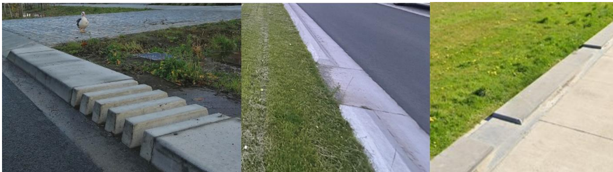
Figuur 4. Voorbeelden van een boordstenen met spleten: (links) in de Fortstraat in Mortsel. Bron: dbpubliekeruimte.info, (midden) in Catershoflaan in Merksem © Aquafin en (rechts) in de Krakeelhoevestraat in Kortrijk. Bron: Google Maps.
