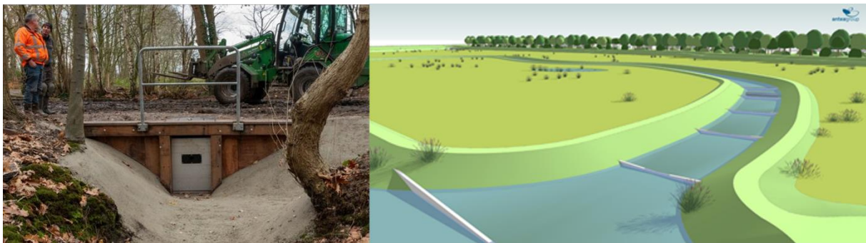
Figuur 44. Links) Regelbare knijpstuw Ulvenhouts bos (Nederland). Bron: Naturetoday.com. Rechts) Vispasseerbare drempels in waterloop afwaarts van natuurgebied. Zo wordt opstuwning gecreëerd zonder dat een vismigratieknelpunt ontstaat. Dit principe werd toegepast bij de herinrichting van 'de Hellekens' in Herentals. Bron: VMM.
