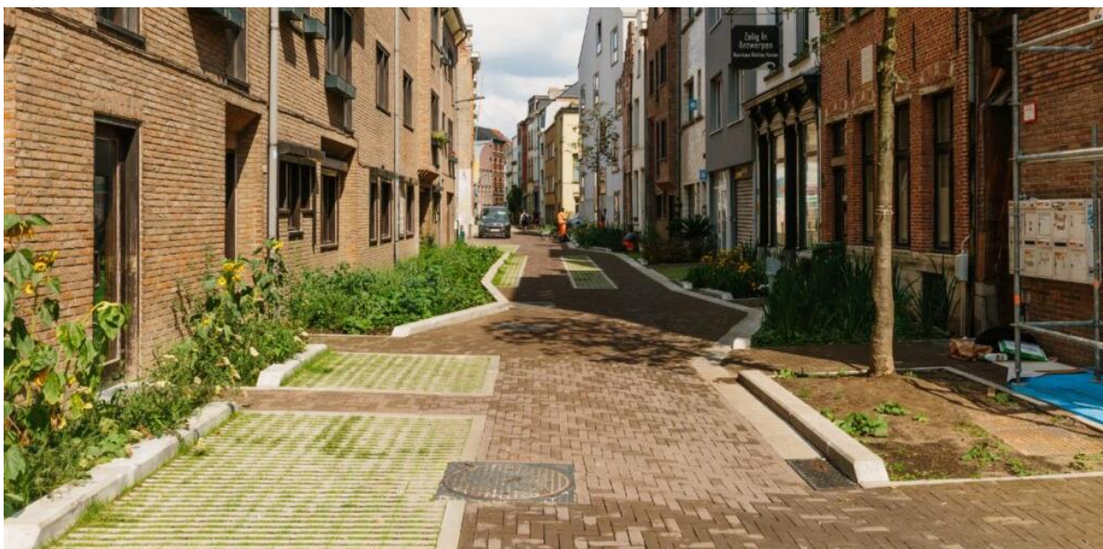
Figuur 1. Voorbeeld van de toepassing van halfverharding voor parkeervakken in de Tuinstraat (Lange Ridderstraat) in Antwerpen (Bron: Stad Antwerpen).
