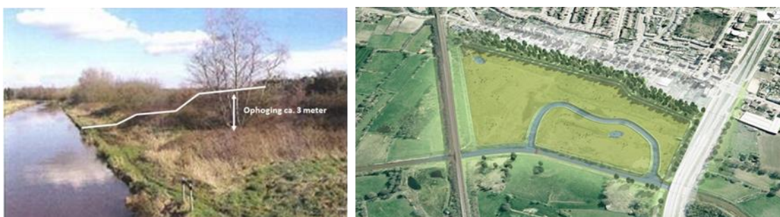
Figuur 43: Herinrichting 'Hellekens' te Herentals d.m.v. afgraven talud. Bron: VMM.
