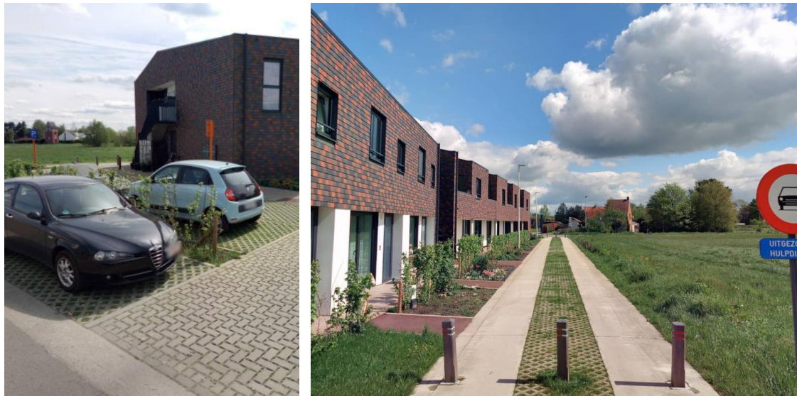
Figuur 18: Aanleg van waterdoorlatende verharding rond een nieuwe ontwikkeling ter hoogte van Schooldijk en Kiezelweg in deelgebied Bevel.
