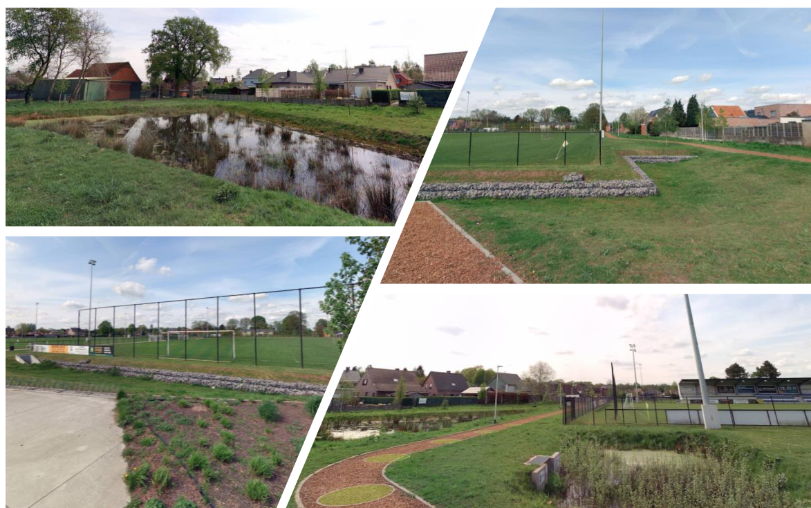
Figuur 13: Buffer- en infiltratiebekkens aan voetbalvelden KFC Nijlen
