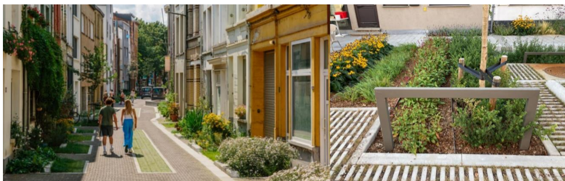
Figuur 2. Vlnr: (1) Ontharding met boven- en ondergrondse infiltratie in centrum Antwerpen. © Aquafin; (2) Infiltrerende plantvakken in Aziëlaan (tuinstraat Wilrijk). © Aquafin
