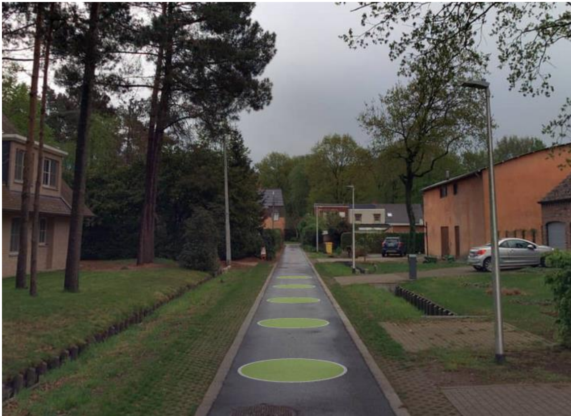
Figuur 17: In de Paddekotseheide werden al enkele straten heraangelegd met waterdoorlatende verharding die functioneert als plaatselijke uitwijkstroken. Een mooi voorbeeld waar de gemeente zijn burgers mee kan inspireren.
