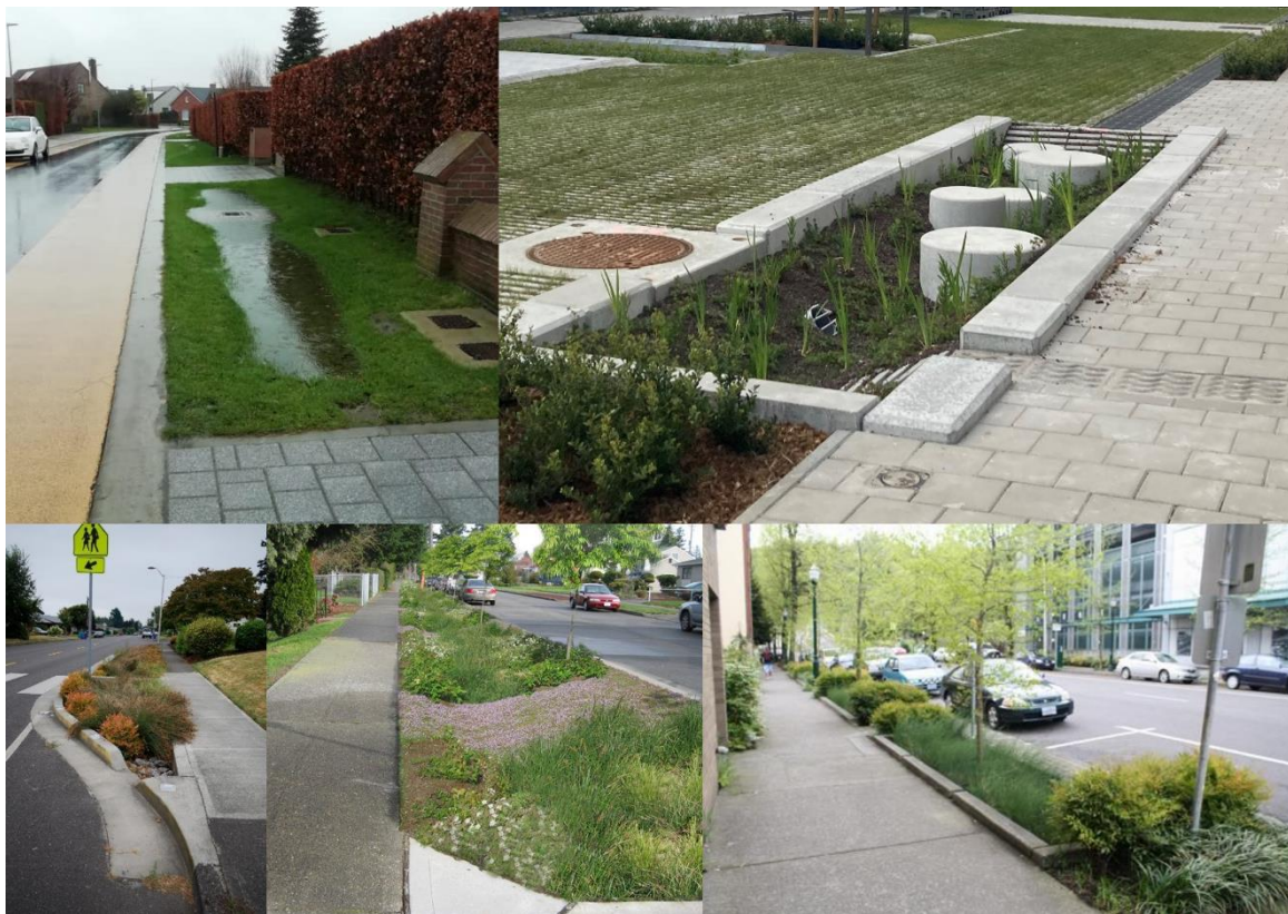
Figuur 4. Vlnr en vbo: (1) Infiltratiekom langs de straat. © Kruisem; (2) Bufferend plantvak (Aziëlaan Wilrijk, tuinstraat). © Aquafin; (4, 5 en 6) Mogelijke vertragingsmaatregelen waarbij de inplanting zoveel mogelijk wordt uitgespreid en focust op water vasthouden. © Aquafin.
