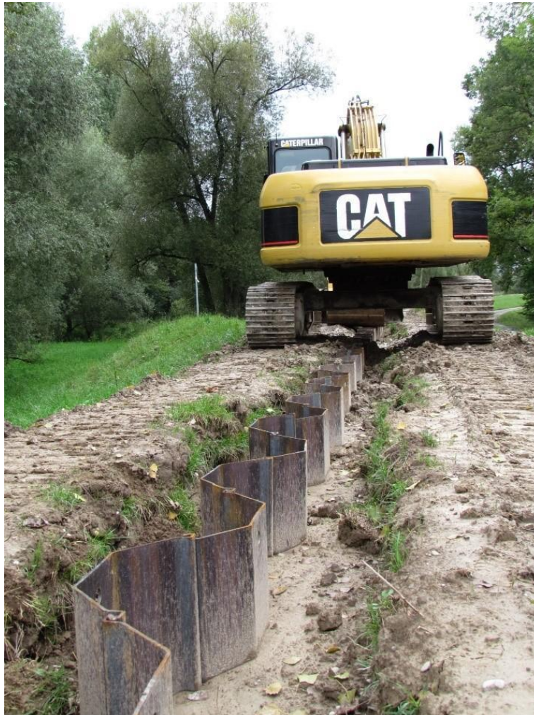
Damwanden die in de oever zijn geplaatst om migratie en graafschade te voorkomen. © R. Campbell-Palmer
