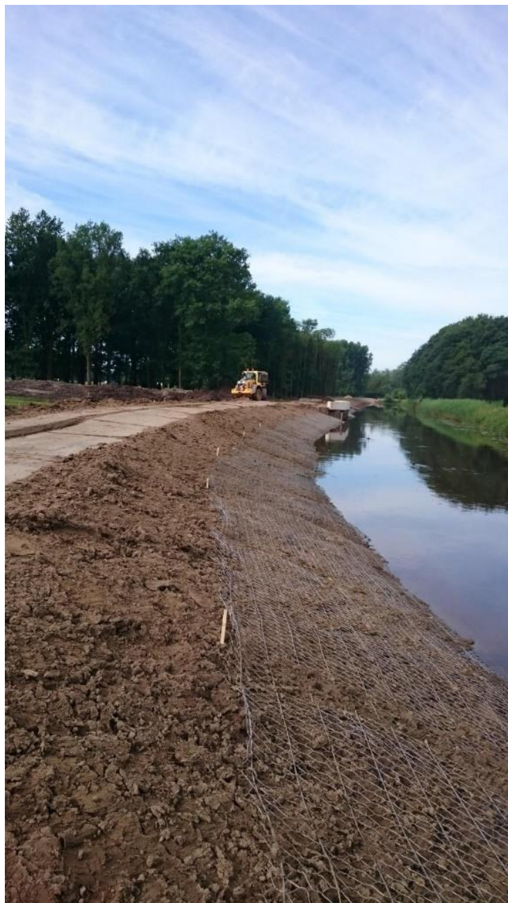
Gaas aangebracht langs een oever bij de Dommel. Op het gaas wordt nog een afdeklaag aangebracht. © Waterschap De Dommel
