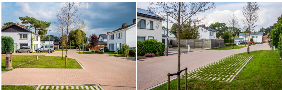
Figuur 31: Uitgevoerd project in de Zilverberkstraat - Leeuwerikstraat in Turnhout.
