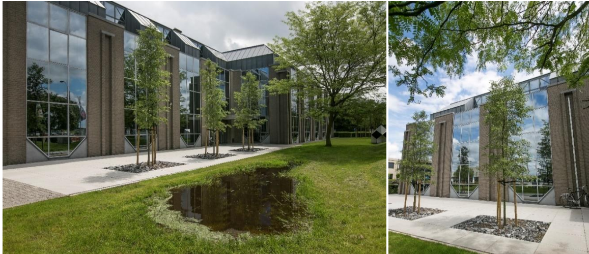
Figuur 4: Toepassing van het Stockholm principe aan het Aquafin hoofdkantoor te Aartselaar.
