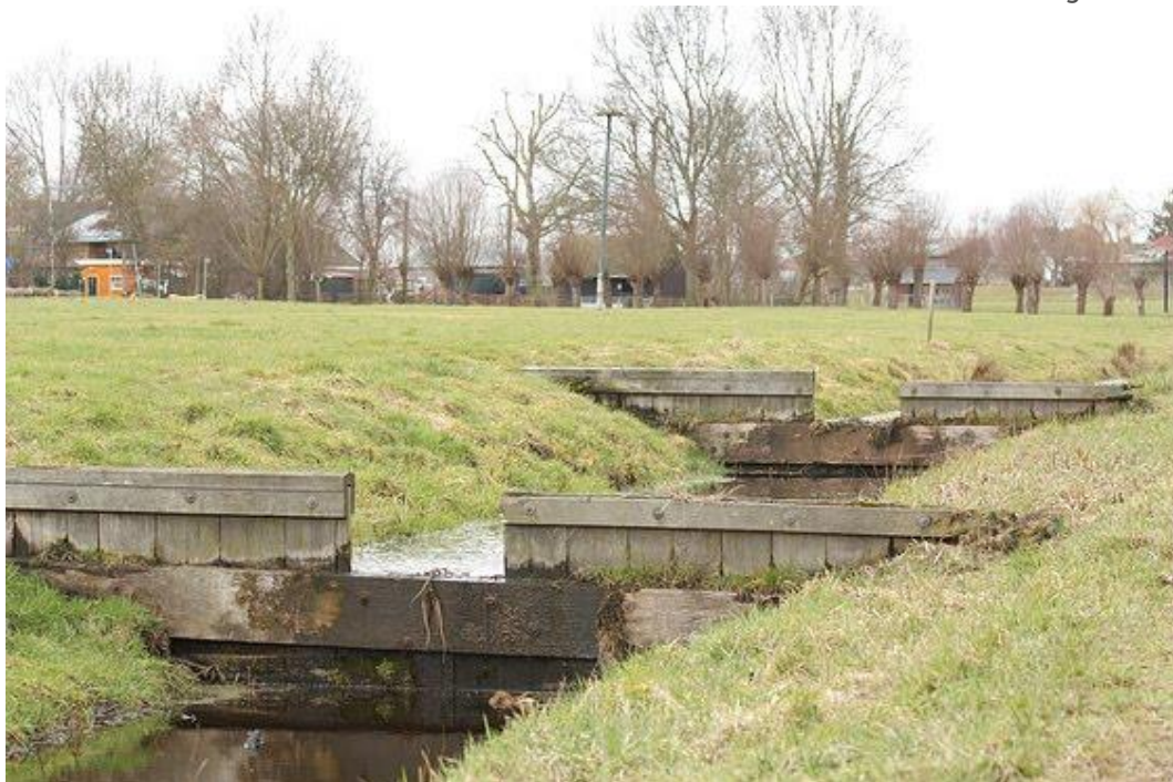
Figuur 37: schotten in grachten vermijden dat al het water wegstroomt en zorgen voor voldoende infiltratie.
