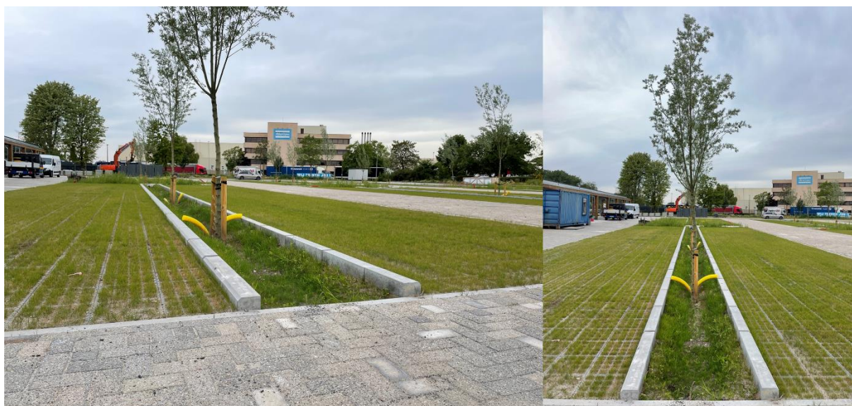
Figuur 66: Parking in waterdoorlatende materialen, hoofdkantoor Aquafin.
