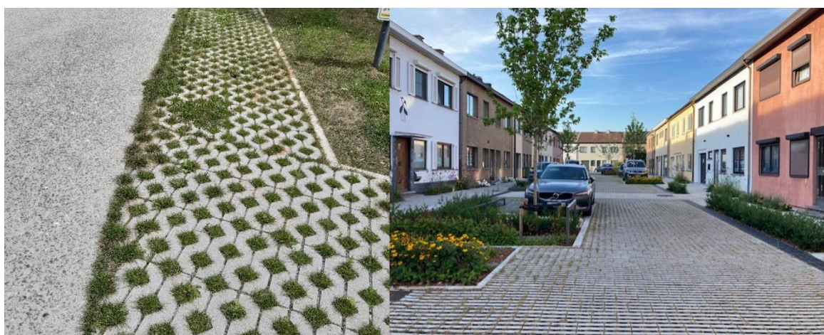
Figuur 58: Vlnr: (1) versmald voet-fietspad met uitwijkmogelijkheid over waterdoorlatende verharding (Overijse - © Aquafin); (2) tuinstraat met zowel rijweg als parkeervakken aangelegd in halfverharding (Aziëlaan, Wilrijk).
