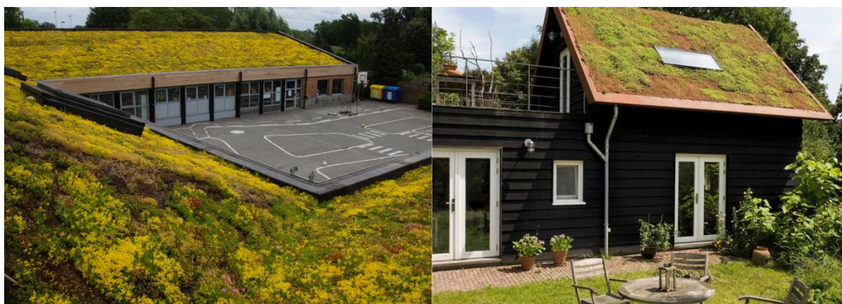
Figuur 42. Voorbeelden van een groendak. Links wordt een groendak toegepast op een groot, weinig hellend dak van de basisschool in Meerdonk Sint-Gillis-Waas. Rechts is het toegepast op het dak van een privé woning. Bron: Blauwgroen Vlaanderen.
