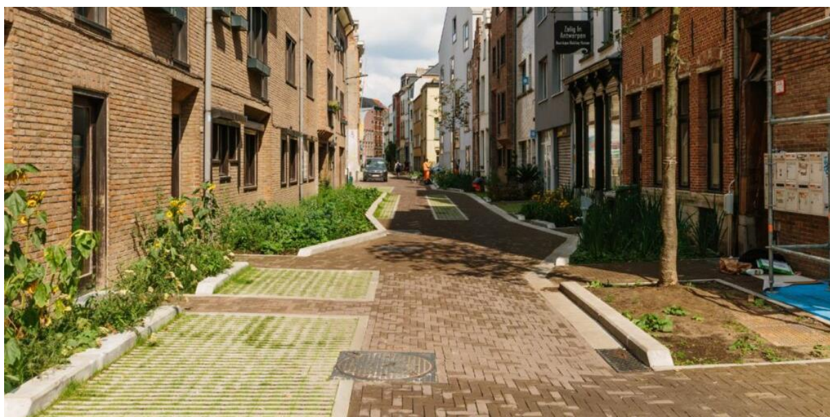
Figuur 32. Voorbeeld van de toepassing van halfverharding voor parkeervakken in de Tuinstraat (Lange Riddersstraat) in Antwerpen (Bron: Stad Antwerpen).
