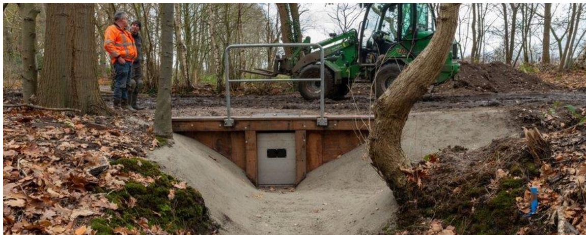
Figuur 53: Regelbare knijpstuw Ulvenhouts bos (Nederland) (bron: www.naturetoday.com )
