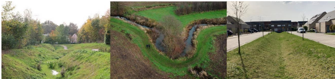
Figuur 35. Blauwgroene afvoerwegen bieden een breed spectrum aan inrichtingsmogelijkheden. (Links) Vuilbeek te Wezembeek-Opem als blauwgroene verbinding ©VMM; (midden) meanderende beek met bufferstroken ©VMM; (rechts) verlaagd aangelegde groenzone in een woonwijk in Kortrijk © Aquafin.
