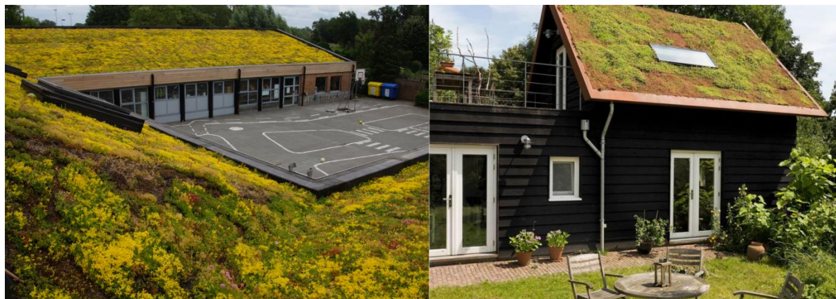
Figuur 37. Voorbeelden van een groendak. Links wordt een groendak toegepast op een groot, weinig hellend dak van de basisschool in Meerdonk Sint-Gillis-Waas. Rechts is het toegepast op het dak van een privé woning. Bron: Blauwgroen Vlaanderen.
