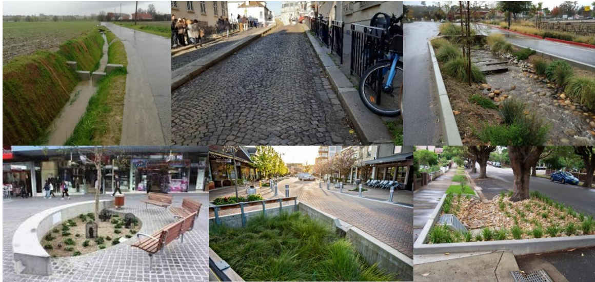
Figuur 27. Vlnr en vbno: (1) Gracht met bufferschotten. © Kruisem; (2) Verhoogde borduren van voetpaden in Parijs. © Aquafin; (3) Doorvoer waterloop in groenberm straat. © svrdesign.com; (4, 5, 6) Mogelijke vertragingsmaatregelen waarbij de focus ligt op het onderbreken van de afstroming. De ingrepen mogen de transportfunctie van de straat niet hinderen en worden ingezet op plaatsen waar extra ruimte ter beschikking is, of als verkeersbegeleidende ingreep. © Aquafin.
