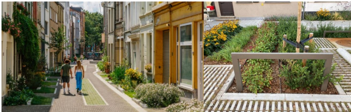
Figuur 25. Vlnr: (1) Ontharding met boven- en ondergrondse infiltratie in centrum Antwerpen. © Aquafin; (2) Infiltrerende plantvakken in Aziëlaan (tuinstraat Wilrijk). © Aquafin
