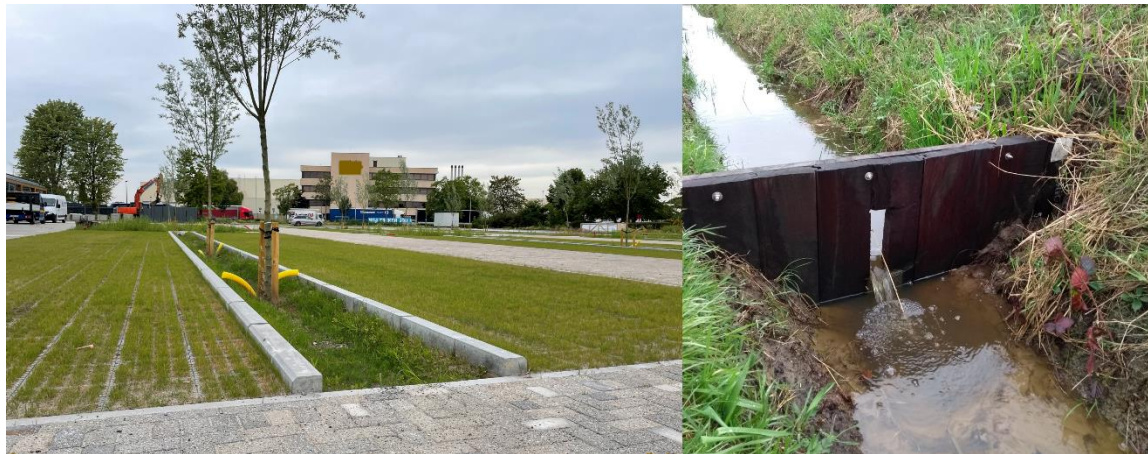
Figuur 6. Voorbeelden van mogelijke maatregelen om afstroom te vermijden van (links) verharde oppervlaktes (parking Aquafin, Aartselaar) en (rechts) in een afvoergracht via een (knijp)stuw (Maldegem). © Aquafin
