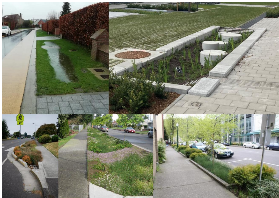
Figuur 26. Vlnr en vbno: (1) Infiltratiekom langs de straat. © Kruisem; (2) Bufferend plantvak (Aziëlaan Wilrijk, tuinstraat). © Aquafin; (4, 5 en 6) Mogelijke vertragsmaatregelen waarbij de inplanting zoveel mogelijk wordt uitgespreid en focust op water vasthouden. © Aquafin.
