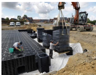
Figuur 4-5 : Voorbeelden van wadi te Zoersel (bovenaan; bron: Pidpa) en ondergrondse infiltratie met kratten (onderaan links; bron: Pidpa) en infiltratieleidingen (onderaan rechts; bron: Vlario, 2017))
