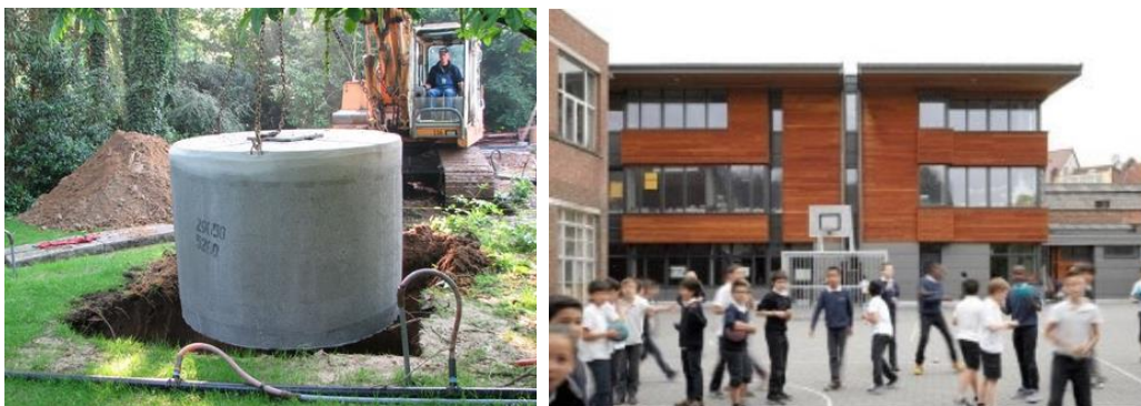
Figuur 4-4 : Het plaatsen van een hemelwaterput voor het opvangen en hergebruiken van hemelwater (links) en de IMMI school te Anderlecht waar hemelwater opgevangen wordt en gereinigd tot drinkwater (rechts; bron: Gids Duurzame Gebouwen .brussels, n.d.)
