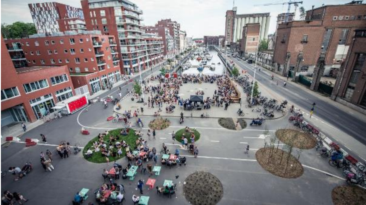
Figuur 20: Eenvoudige perforaties van de bestaande verharding zoals hier werd gebruikt in de tijdelijke inrichting van een plein in Leuven, kunnen in Duffelshoek de afstromingsnelheid verlagen. De perforaties kunnen bijvoorbeeld dienen als verkeersgeleider en worden in het ideale geval, uitgelijnd met de straatkolken zodat een overloop naar de riolering mogelijk is zon. (OPEK-plein Leuven – Lars Bauwens)
