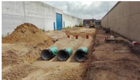
Figuur 4-5 : Voorbeelden van wadi te Zoersel (bovenaan; bron: Pidpa) en ondergrondse infiltratie met kratten (onderaan links; bron: Pidpa) en infiltratieleidingen (onderaan rechts; bron: Vlaro, 2017))
