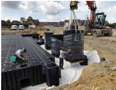
Figuur 4-5 : Voorbeelden van wadi te Zoersel (bovenaan; bron: Pidpa) en ondergrondse infiltratie met kratten (onderaan links; bron: Pidpa) en infiltratieleidingen (onderaan rechts; bron: Vlaro, 2017))
