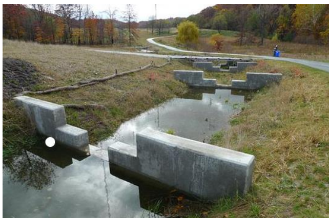
Figuur_Bijlage D-4: Voorbeelden van baangrachten gecompartmenteerd door middel van betonnen stuwende met overloopprofiel. Dergelijke stuwende zijn te verkiezen boven knijpconstructies met een opening onderaan
