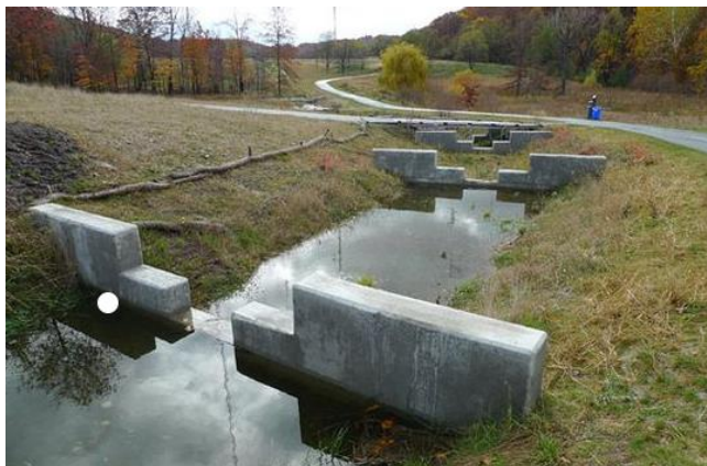
Figuur_Bijlage D-4: Voorbeelden van baangrachten gecompartmenteerd door middel van betonnen stuwen met overloopprofiel. Dergelijke stuwen zijn te verkiezen boven knijpconstructies met een opening onderaan
