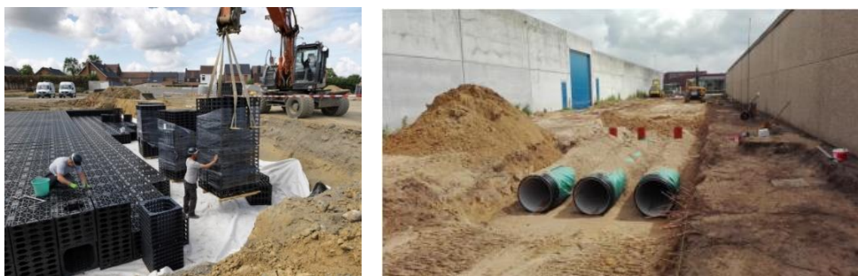
Figuur_Bijlage D-8: Voorbeelden van ondergrondse infiltratie met kratten (links; bron: Pidpa) en infiltratieleidingen (rechts; bron: Vlario, 2017)
