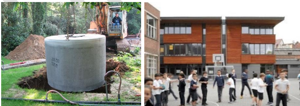
Figuur 4-4 : Het plaatsen van een hemelwaterput voor het opvangen en hergebruiken van hemelwater (links) en de IMMI school te Anderlecht waar hemelwater opgevangen wordt en gereinigd tot drinkwater (rechts; bron: Gids Duurzame Gebouwen .brussels, n.d.)
