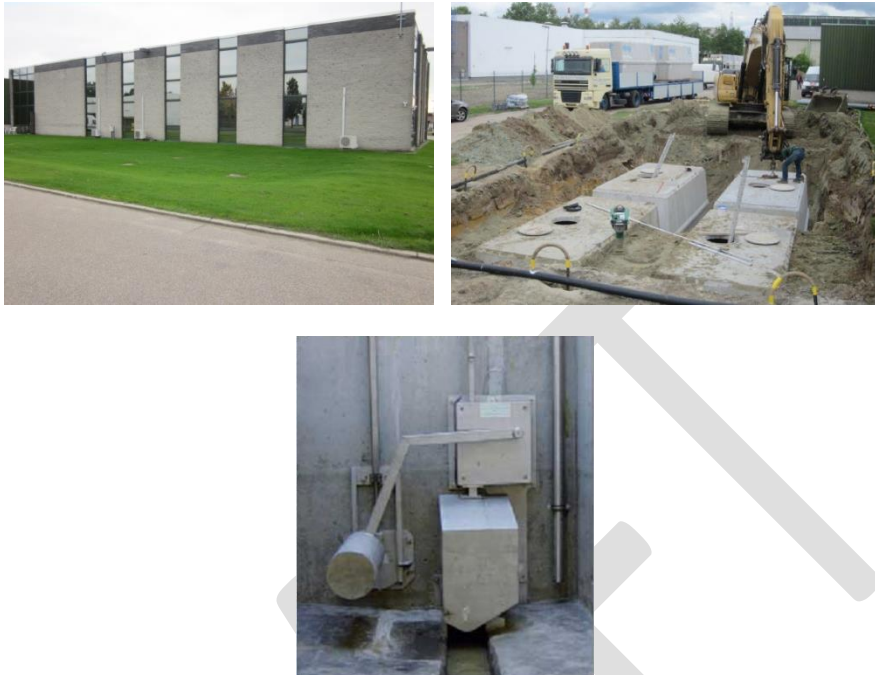
Figuur 4-6 : Voorbeelden van het bovengronds (bovenaan links; bron: Vlario, 2014) of ondergronds bufferen (bovenaan rechts; bron: Vlario, 2014) en van een Hydroslide debietbegrenzer (onderaan; bron: Steinhardt Wassertechnik GmbH, n.d.)
