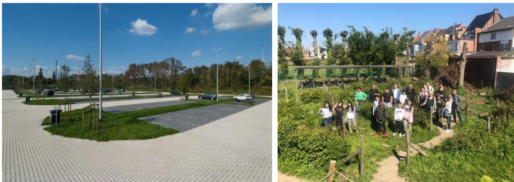
Figuur 4-3 : Voorbeelden van het toepassen van ontharden op een carpoolparking te Hasselt (links) en de ontharde speelplaats van basisschool De Knipoog te Vilvoorde (rechts; bron: Provincie Vlaams-Brabant, 2019))
