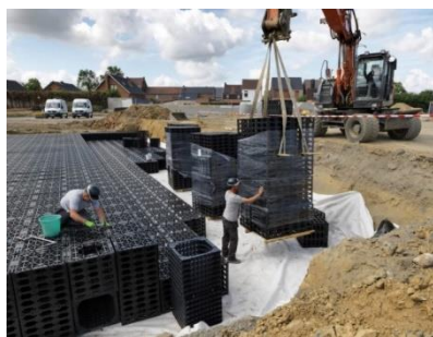
Figuur 4-5 : Voorbeelden van wadi te Zoersel (bovenaan; bron: Pidpa) en ondergrondse infiltratie met kratten (onderaan links; bron: Pidpa) en infiltratieleidingen (onderaan rechts; bron: Vlarío, 2017))
