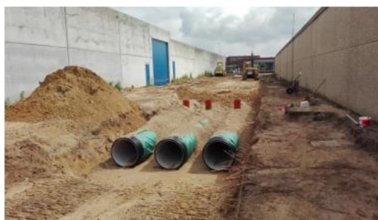
Figuur 4-5 : Voorbeelden van wadi te Zoersel (bovenaan; bron: Pidpa) en ondergrondse infiltratie met kratten (onderaan links; bron: Pidpa) en infiltratieleidingen (onderaan rechts; bron: Vlarío, 2017))
