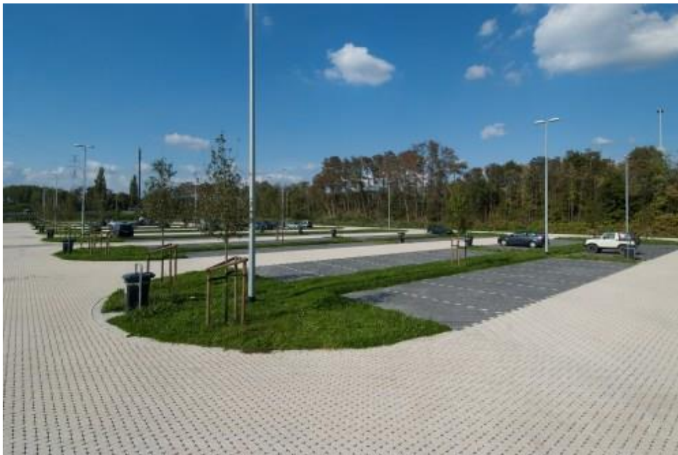
Figuur 3-2 Ontharde carpoolparking Hasselt (foto: Ebema)
